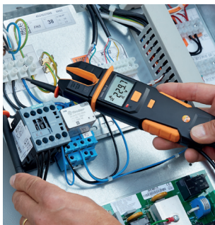
Misura della tensione su un compressore.
